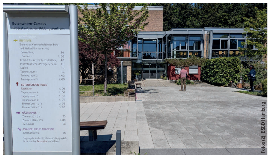
das Schulungs- und Seminargebäude
